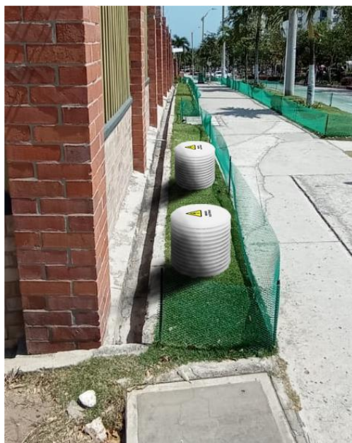
Ilustración 4 Esquemático de torreta de ventilación remota
